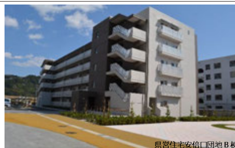
県営住宅安倍口団地B棟
