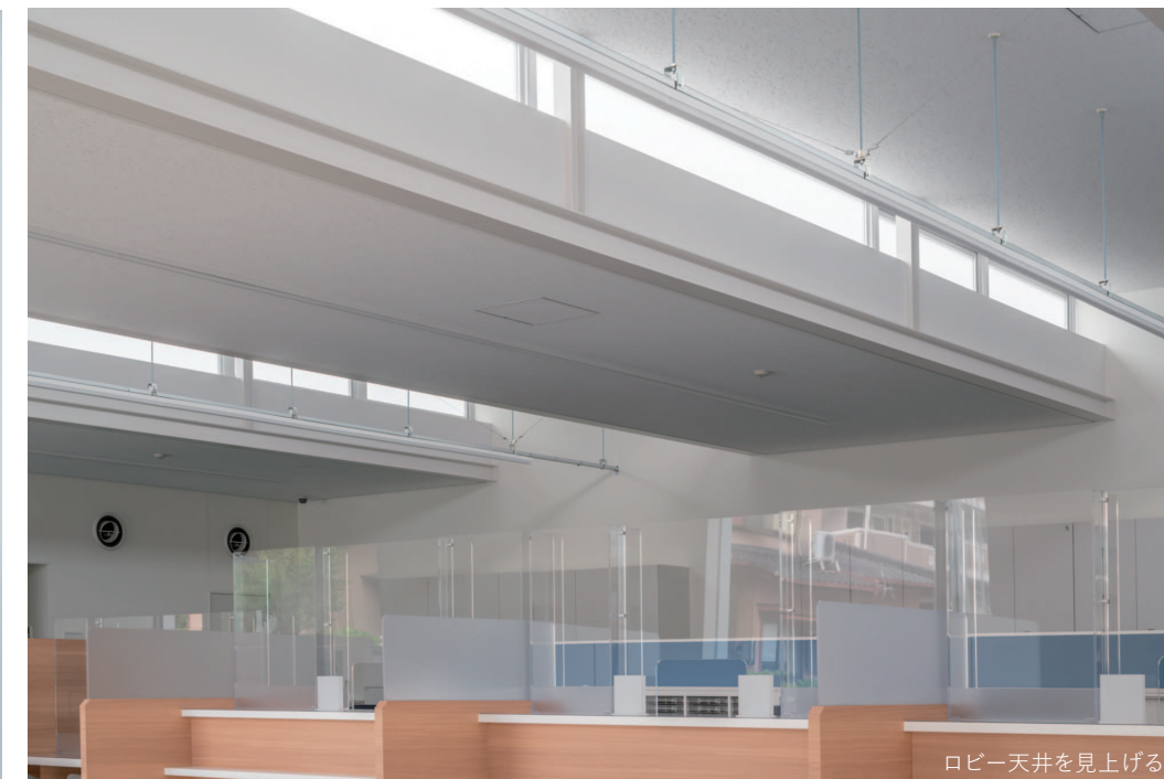
ロビー天井を見上げる
