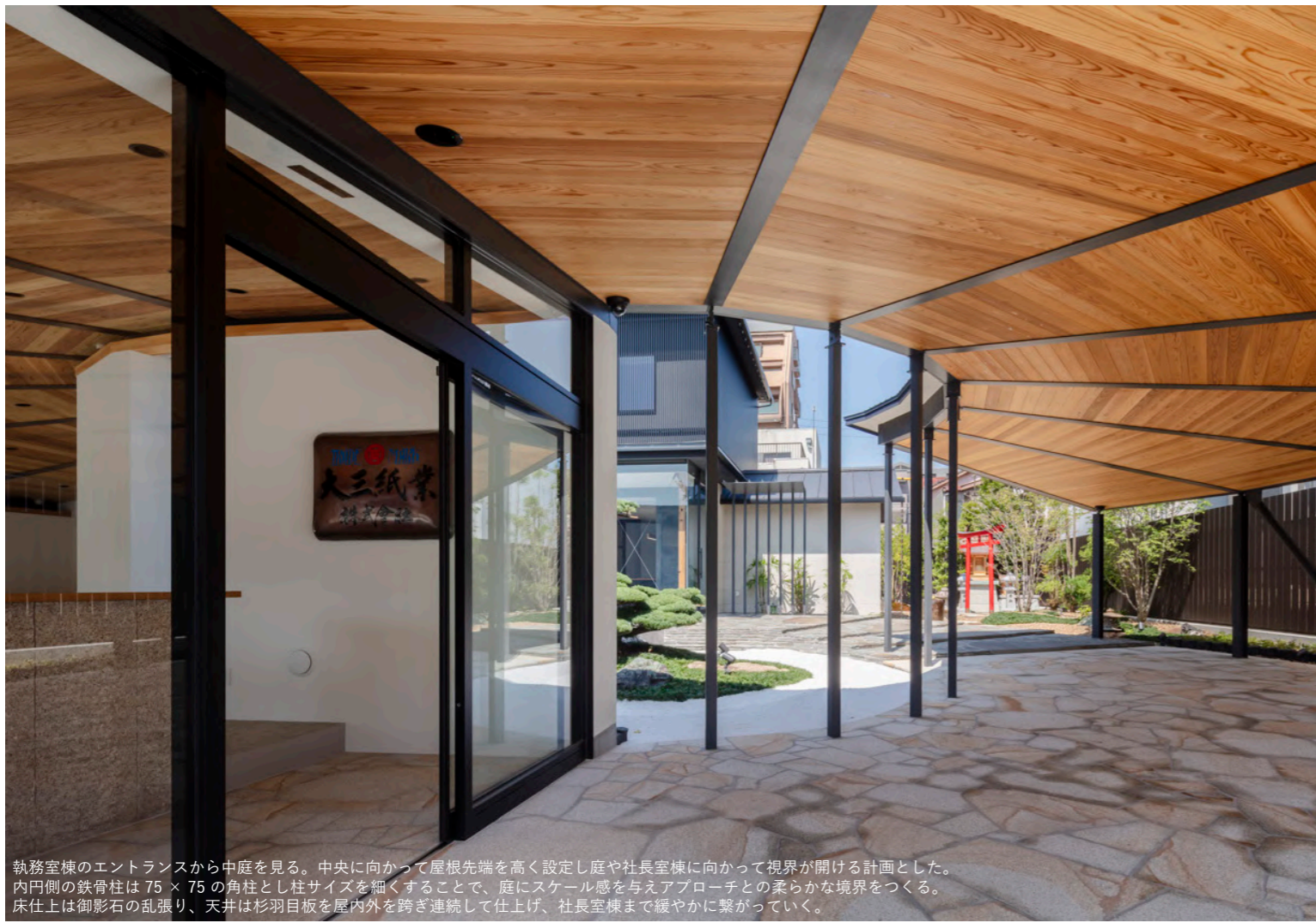
ラウンジから北を見る。新設したサッシによって庭への抜けを創出。既存の木柱は柱に刻まれた歴史を表現するため、CL塗装の現し仕上げとした。また、造作・職製家具を空間に応じて組み合わせ、全体の調和を図った。
