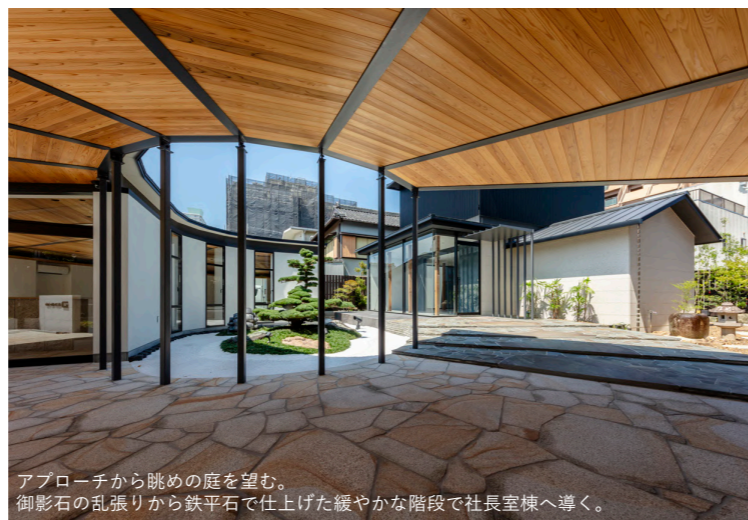
執務室棟のエントランスから中庭を見る。中央に向かって屋根先端を高く設定し庭や社長室棟に向かって視界が開ける計画とした。内円側の鉄骨柱は75×75の角柱とし柱サイズを細くすることで、庭にスケール感を与えアプローチとの柔らかな境界をつくる。床仕上は御影石の乱張り、天井は杉羽目板を屋内外を跨ぎ連続して仕上げ、社長室棟まで緩やかに繋がっていく。
