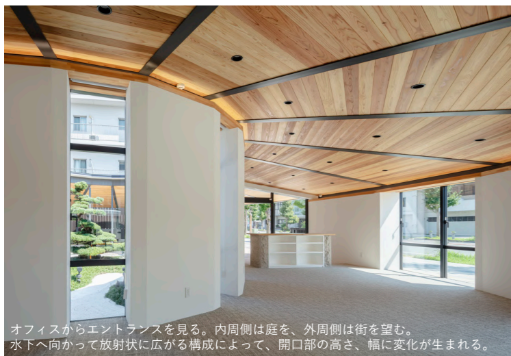
執務室棟のエントランスから中庭を見る。中央に向かって屋根先端を高く設定し庭や社長室棟に向かって視界が開ける計画とした。内円側の鉄骨柱は75×75の角柱とし柱サイズを細くすることで、庭にスケール感を与えアプローチとの柔らかな境界をつくる。床仕上は御影石の乱張り、天井は杉羽目板を屋内外を跨ぎ連続して仕上げ、社長室棟まで緩やかに繋がっていく。
