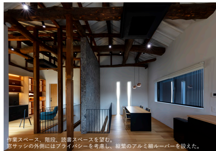
ラウンジから南を見る。奥の壁は炭を混ぜた左官仕上とし明暗の対比を生むことで、中庭を美しく切り取る。また、右手の構造壁とキッチンカウンターを同仕上げとすることで一体感を持たせた。
