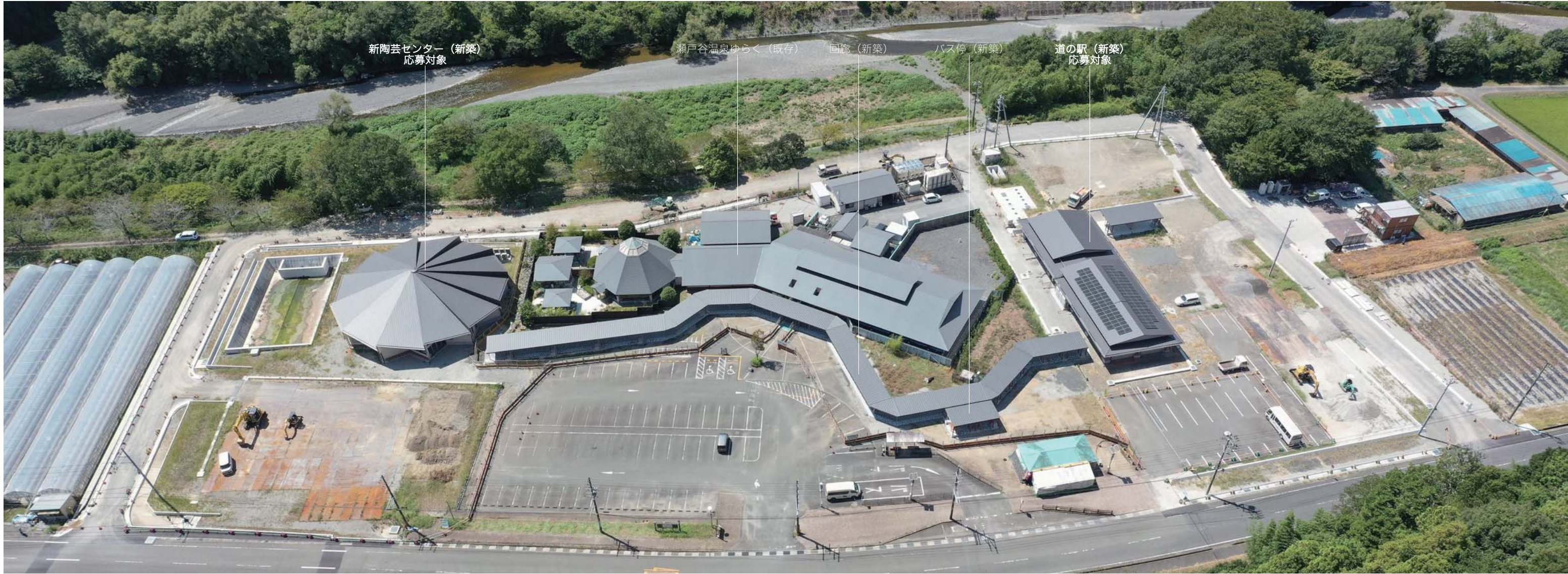
2025年9月時点 敷地上空より
