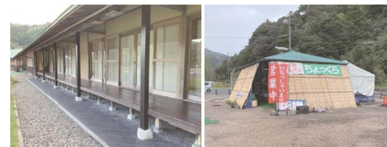
「瀬戸谷温泉ゆらく」の軒下空間「ちよっくら」の開放的な作りの二つを継承した道の駅
