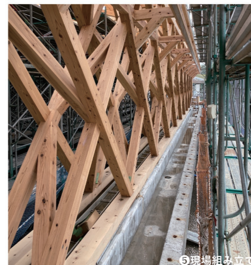
⑤現場組み立て
