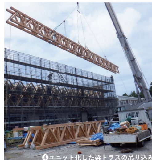
④ユニット化した梁トラスの吊り込み
