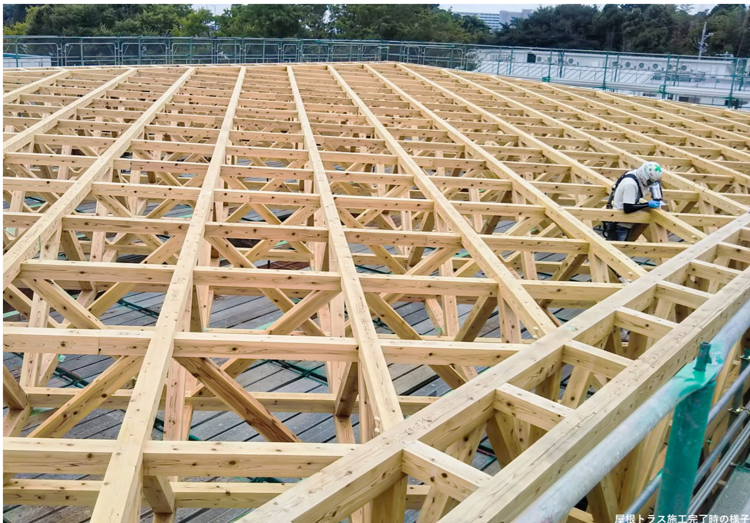
屋根トラス施工完了時の様子
