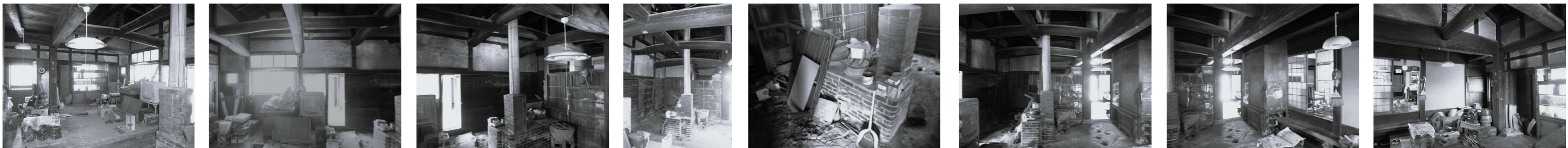
かまどのある三和土土間の「内どま」は、その昔の改修で一部板張りされ、流しや収納棚が増設され使われていたようです。天井は張られてなく、大黒柱に刺さる大きな梁や、二重三重に重なる堅牢な丸太梁組みが見られています。
