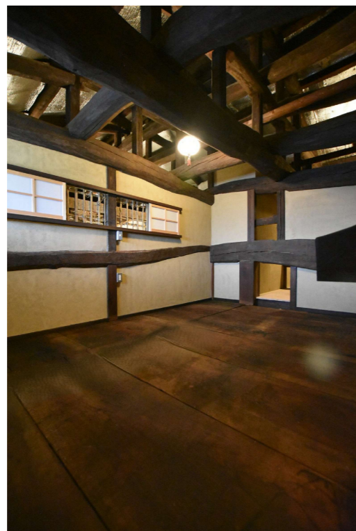
大黒柱と大きな梁、丸太梁は水拭きされ米ぬかで磨き上げられ、土間は断熱され少し嵩上げされ墨モルタルで仕上げられました。玄関サッシは取り外され、使われてなかった大戸を蔵戸風に改修して復活させました。じょちゅうべやは玄関収納に、梯子階段もまわり階段にかけ直し、小屋裏部屋にもスムーズに昇降出来るように... 小屋裏部屋はご主人の秘密基地に。屋根の室内側にはアルミ遮熱シートを張り日射熱や冷放射を跳ね返してもらいます。おかつては北の縁側を復活させ、北庭に視線を広げ、天井も1/3ほど取り外し、勾配天井として梁組みを見せダイナミックな空間の居間として生まれ変わりました。
