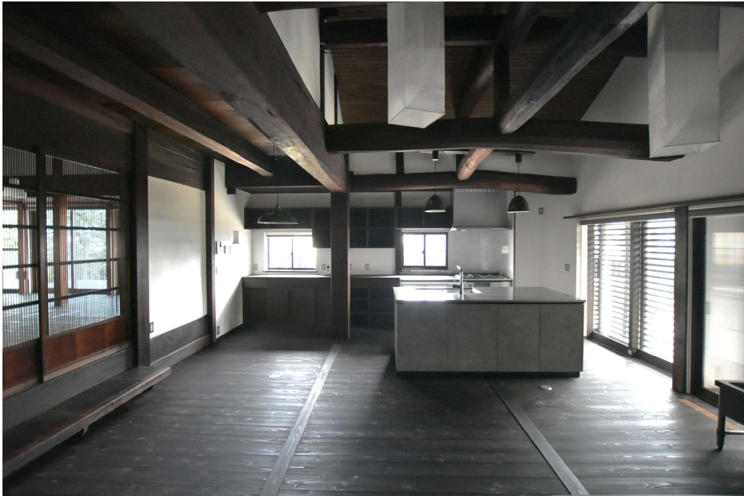
かまどは新ストーブに姿を変え、かまどを形づくっていた耐火レンガは、東屋のBBQコンロに、大中小の三つの羽釜もここで使われ続けていくこととなりました。かまどを仕上げていた化粧レンガは、新ストーブ背面に遮熱壁として使われています。東屋には長年使われていなかった井戸もタイル流し台と共に今回復旧しました。丸太梁は水洗いし米ぬかで磨かれ、漆喰壁も塗り直され、三和土土間だった「内どま」は玄関土間より少し高く床張りされ、クッキングストープのある食堂台所に少しだけ姿を変えました...
