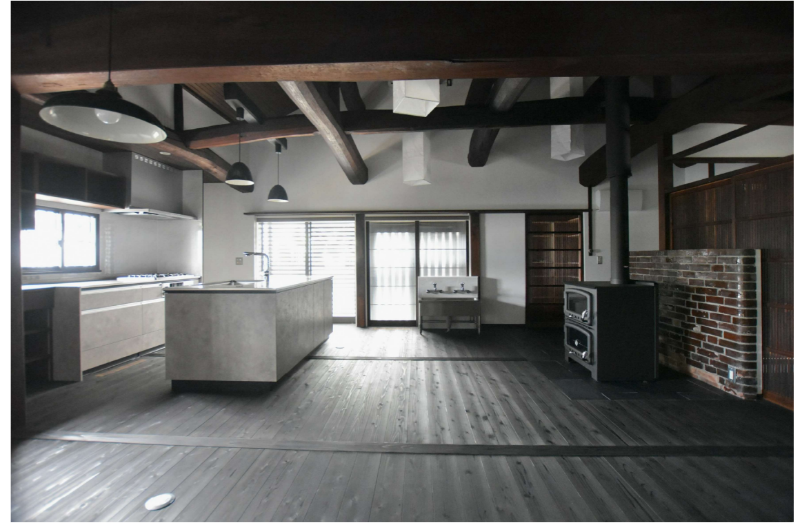
かまどは新ストーブに姿を変え、かまどを形づくっていた耐火レンガは、東屋のBBQコンロに、大中小の三つの羽釜もここで使われ続けていくこととなりました。かまどを仕上げていた化粧レンガは、新ストーブ背面に遮熱壁として使われています。東屋には長年使われていなかった井戸もタイル流し台と共に今回復旧しました。丸太梁は水洗いし米ぬかで磨かれ、漆喰壁も塗り直され、三和土土間だった「内どま」は玄関土間より少し高く床張りされ、クッキングストープのある食堂台所に少しだけ姿を変えました...
