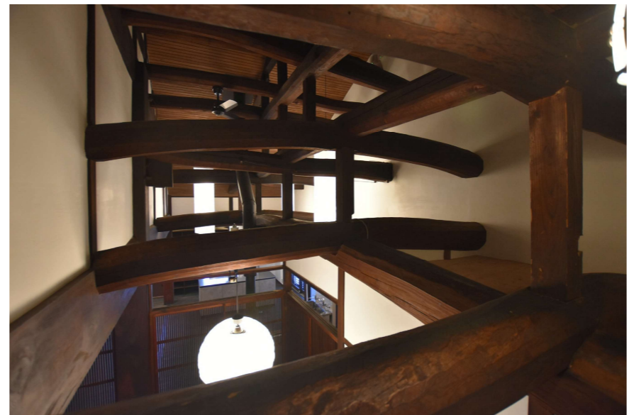
大黒柱と大きな梁、丸太梁は水拭きされ米ぬかで磨き上げられ、土間は断熱され少し嵩上げされ墨モルタルで仕上げられました。玄関サッシは取り外され、使われてなかった大戸を蔵戸風に改修して復活させました。じょちゅうべやは玄関収納に、梯子階段もまわり階段にかけ直し、小屋裏部屋にもスムーズに昇降出来るように... 小屋裏部屋はご主人の秘密基地に。屋根の室内側にはアルミ遮熱シートを張り日射熱や冷放射を跳ね返してもらいます。おかつては北の縁側を復活させ、北庭に視線を広げ、天井も1/3ほど取り外し、勾配天井として梁組みを見せダイナミックな空間の居間として生まれ変わりました。
