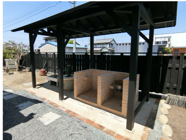
かまどは新ストーブに姿を変え、かまどを形づくっていた耐火レンガは、東屋のBBQコンロに、大中小の三つの羽釜もここで使われ続けていくこととなりました。かまどを仕上げていた化粧レンガは、新ストーブ背面に遮熱壁として使われています。東屋には長年使われていなかった井戸もタイル流し台と共に今回復旧しました。丸太梁は水洗いし米ぬかで磨かれ、漆喰壁も塗り直され、三和土土間だった「内どま」は玄関土間より少し高く床張りされ、クッキングストープのある食堂台所に少しだけ姿を変えました...
