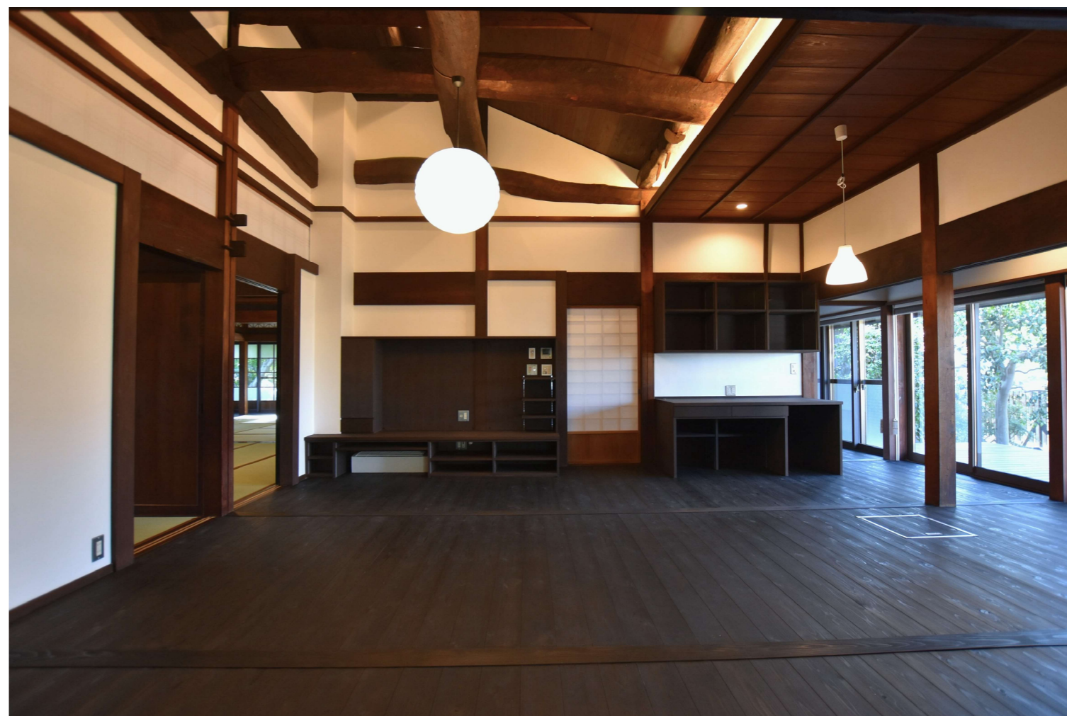
大黒柱と大きな梁、丸太梁は水拭きされ米ぬかで磨き上げられ、土間は断熱され少し嵩上げされ墨モルタルで仕上げられました。玄関サッシは取り外され、使われてなかった大戸を蔵戸風に改修して復活させました。じょちゅうべやは玄関収納に、梯子階段もまわり階段にかけ直し、小屋裏部屋にもスムーズに昇降出来るように... 小屋裏部屋はご主人の秘密基地に。屋根の室内側にはアルミ遮熱シートを張り日射熱や冷放射を跳ね返してもらいます。おかつては北の縁側を復活させ、北庭に視線を広げ、天井も1/3ほど取り外し、勾配天井として梁組みを見せダイナミックな空間の居間として生まれ変わりました。
