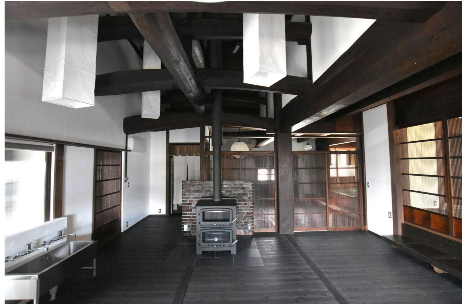
かまどは新ストーブに姿を変え、かまどを形づくっていた耐火レンガは、東屋のBBQコンロに、大中小の三つの羽釜もここで使われ続けていくこととなりました。かまどを仕上げていた化粧レンガは、新ストーブ背面に遮熱壁として使われています。東屋には長年使われていなかった井戸もタイル流し台と共に今回復旧しました。丸太梁は水洗いし米ぬかで磨かれ、漆喰壁も塗り直され、三和土土間だった「内どま」は玄関土間より少し高く床張りされ、クッキングストープのある食堂台所に少しだけ姿を変えました...
