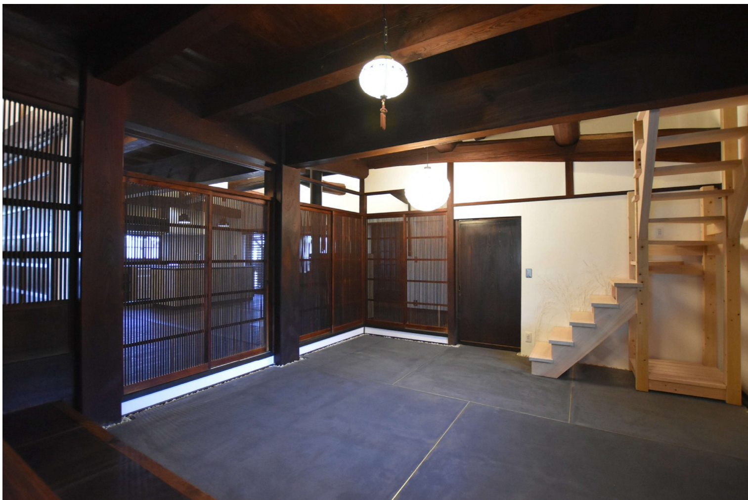
大黒柱と大きな梁、丸太梁は水拭きされ米ぬかで磨き上げられ、土間は断熱され少し嵩上げされ墨モルタルで仕上げられました。玄関サッシは取り外され、使われてなかった大戸を蔵戸風に改修して復活させました。じょちゅうべやは玄関収納に、梯子階段もまわり階段にかけ直し、小屋裏部屋にもスムーズに昇降出来るように... 小屋裏部屋はご主人の秘密基地に。屋根の室内側にはアルミ遮熱シートを張り日射熱や冷放射を跳ね返してもらいます。おかつては北の縁側を復活させ、北庭に視線を広げ、天井も1/3ほど取り外し、勾配天井として梁組みを見せダイナミックな空間の居間として生まれ変わりました。
