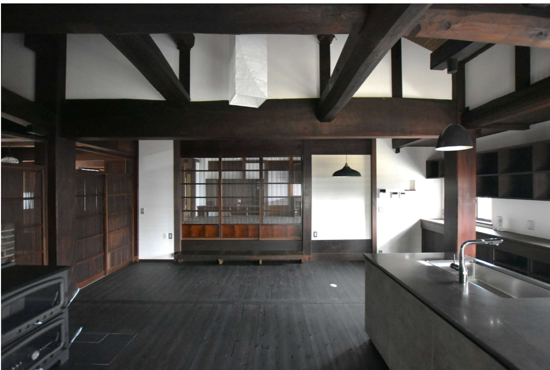
かまどは新ストーブに姿を変え、かまどを形づくっていた耐火レンガは、東屋のBBQコンロに、大中小の三つの羽釜もここで使われ続けていくこととなりました。かまどを仕上げていた化粧レンガは、新ストーブ背面に遮熱壁として使われています。東屋には長年使われていなかった井戸もタイル流し台と共に今回復旧しました。丸太梁は水洗いし米ぬかで磨かれ、漆喰壁も塗り直され、三和土土間だった「内どま」は玄関土間より少し高く床張りされ、クッキングストープのある食堂台所に少しだけ姿を変えました...
