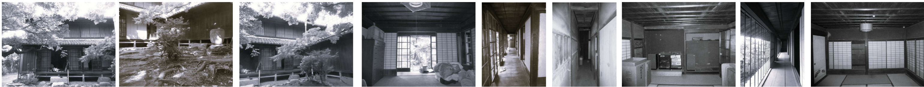
雁行する主屋とはなれば内庭に面します。主屋がまだかや葺きだった頃増築されたようで、高さのあるコンクリート束石の上に土台が乗せられていました。離れ2階の一段上がったまわり縁からの内庭の眺めは圧巻で非日常を感じられる空間です。
