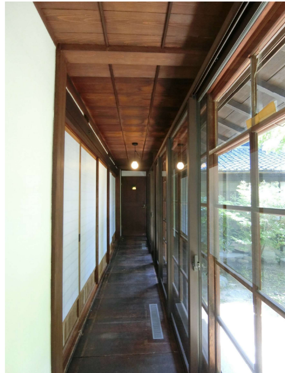
屋根と外壁はそのままに、壁の漆喰塗りと木部は古色塗装で仕上げを保護。今回改修では古民家の寒いを解決するため、まずは通風系の高い床下空間を閉じ、土間コンクリートと充填断熱で室内空間化し空気循環させます。そこに床下エアコンを加えることで、冷たかった床は穏やかな暖かさを感じる床に...小舞土壁の透気・透湿・調湿の効果を遮ることなく、土壁の内側にポリエステル断熱材を充填し、可変透湿気密シートで隙間風を防ぐ。木製建具の内側には内窓&ハニカムサーモクリーン...この壁構造が、古民家の透湿・透気・調湿・蓄熱の効果を引き継ぎ、新たに断熱・気密を加えることで、季節を問わず一年中快適な空間をつくり出すことが出来ます。
