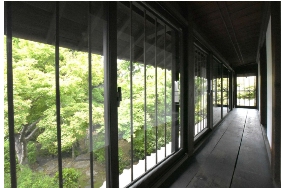
屋根と外壁はそのままに、壁の漆喰塗りと木部は古色塗装で仕上げを保護。今回改修では古民家の寒いを解決するため、まずは通風系の高い床下空間を閉じ、土間コンクリートと充填断熱で室内空間化し空気循環させます。そこに床下エアコンを加えることで、冷たかった床は穏やかな暖かさを感じる床に...小舞土壁の透気・透湿・調湿の効果を遮ることなく、土壁の内側にポリエステル断熱材を充填し、可変透湿気密シートで隙間風を防ぐ。木製建具の内側には内窓&ハニカムサーモクリーン...この壁構造が、古民家の透湿・透気・調湿・蓄熱の効果を引き継ぎ、新たに断熱・気密を加えることで、季節を問わず一年中快適な空間をつくり出すことが出来ます。
