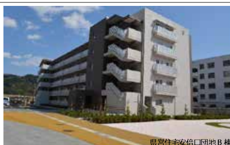
県営住宅安倍口団地B棟
