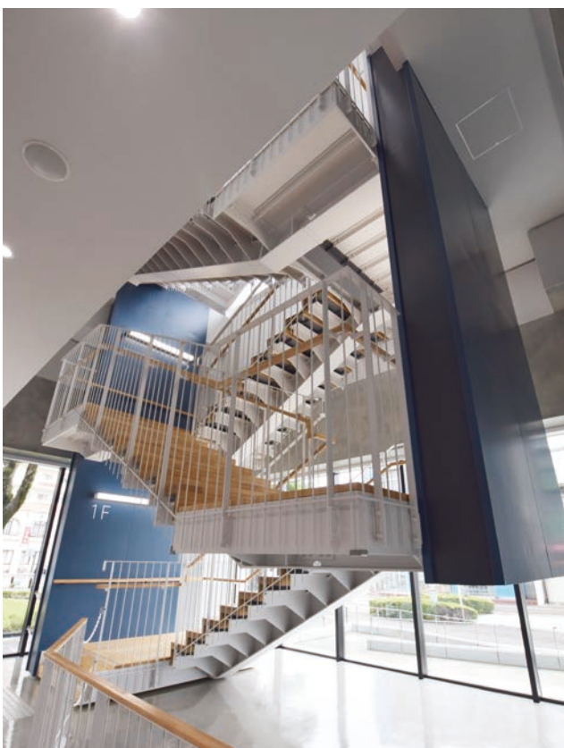
中間免震で2階の梁に固定されている階段
