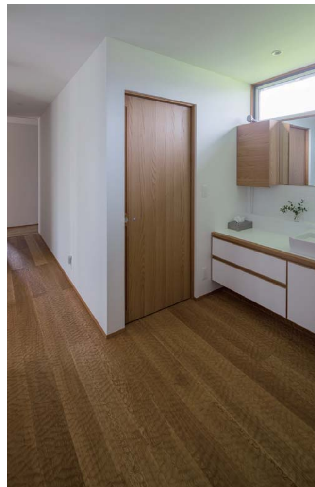
洗面と廊下を見る。床材は居間と同じフローリングをなぐり加工したものを採用し、陰影を感じる空間とした。
