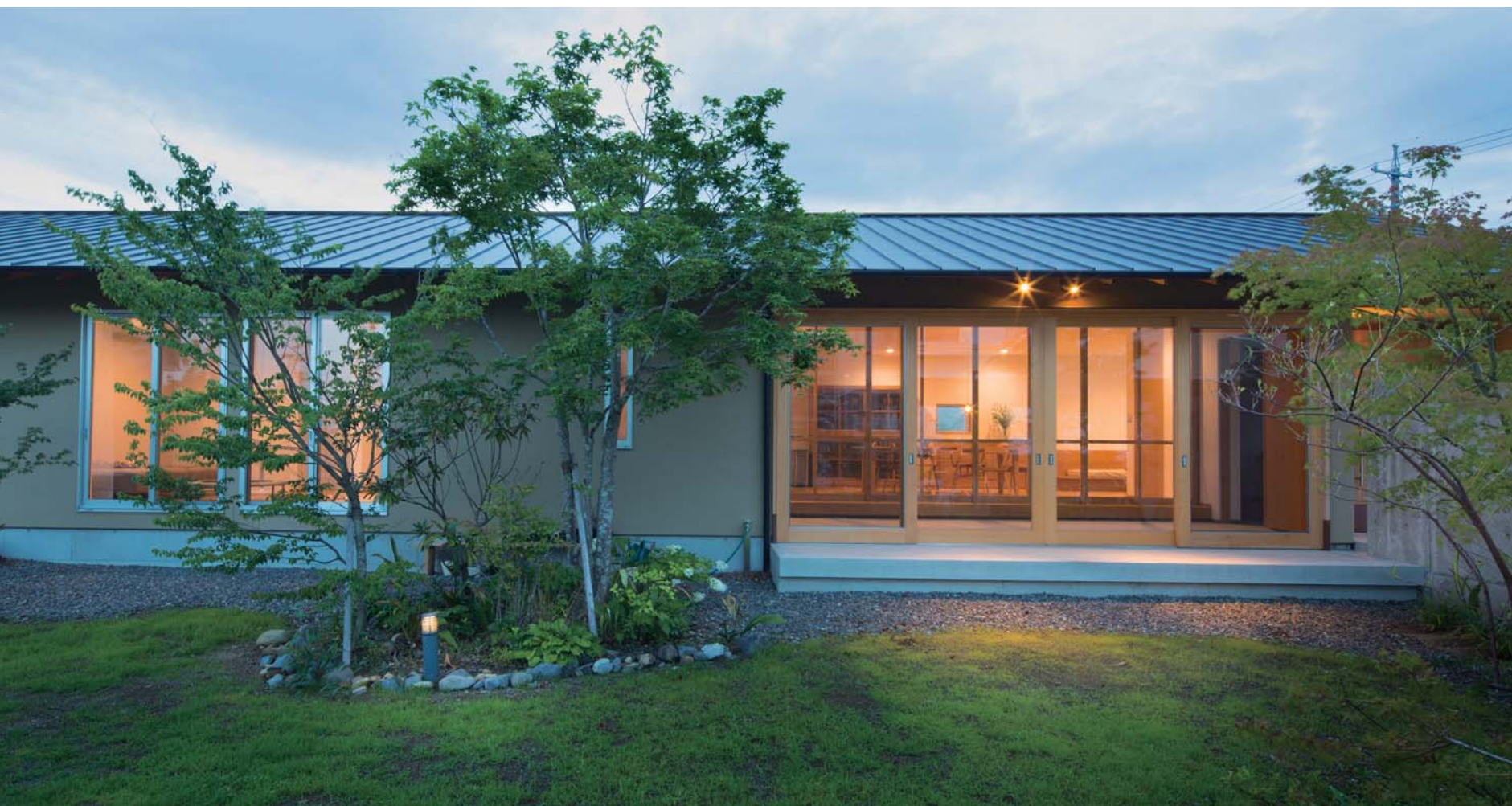
庭から居間をみる。使い方によって室内と屋外は近づいたり、遠ざかったり空間の滲み方は変容する。
