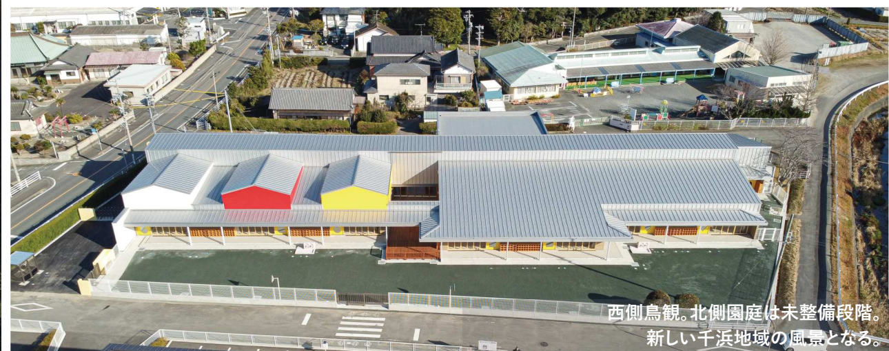
西側鳥観。北側園庭は未整備段階。 工事中は仮設園舎を建てずに既存千浜保育園を利用。
