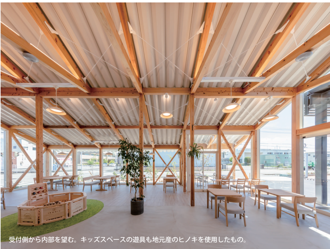
ショールーム棟入口側から内部を望む。 全ての木構造体はしずおか優良木材を使用 受付周辺にも地元産のスギ羽目板を貼った
