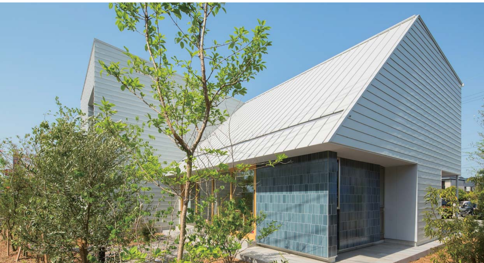
敷地東側から建物外観を見る
