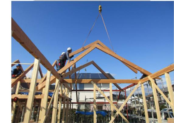
現場にて先行で手加工した扱首梁を一つ一つ丁寧に桁に架けている様子。屋根の小屋梁や束、棟等がない為、通りの確認と、建て起し確認は特に慎重に行なった。
