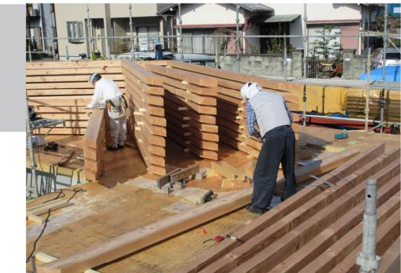
先行して床下地を造り現場を加工場として利用し、大きな化粧の鋲首梁一つ一つ丁寧に手加工している様子。鋲首梁の頂部は、ホームコネクターという隠蔽金物を使用することで、金物の見えない木組みの美しい屋根組が実現できた。
