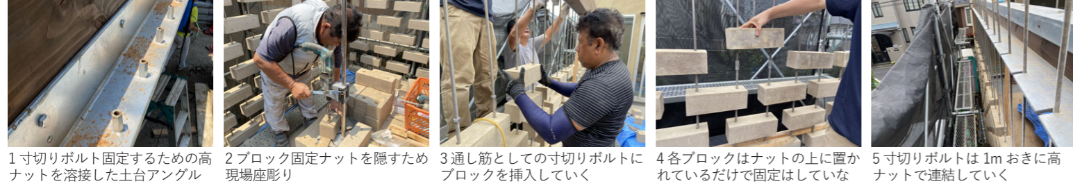
3 通し筋としての寸切りボルトに
