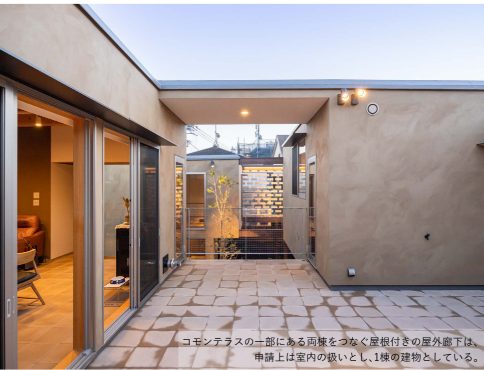
バルコニーから見下ろす。1階外部空間の床は関東ローム黒土ブロック平板敷き。両棟を繋いでいる梁が水平力を負担する。また梁とテラス下の基礎により、両棟は一体の構造として扱っている。
