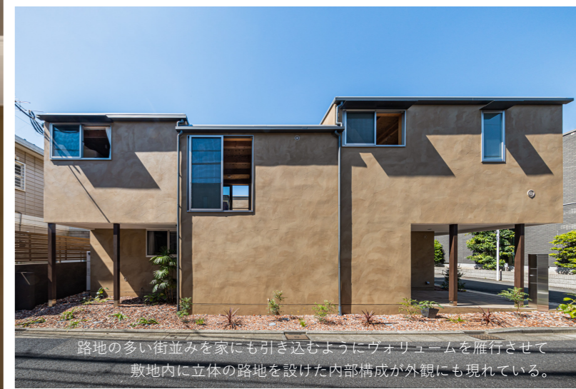
外壁は関東ローム赤土配合左官仕上げとし、土の表情をもたせた。
