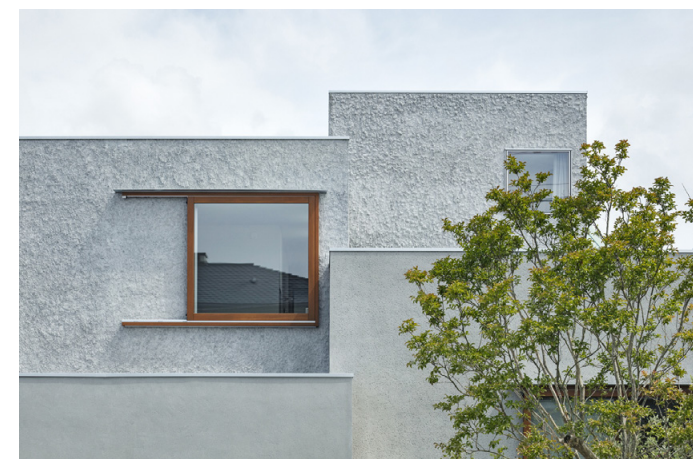
南ファサードを拡大した様子。手前から1段目、2段目、3段目、4段目
