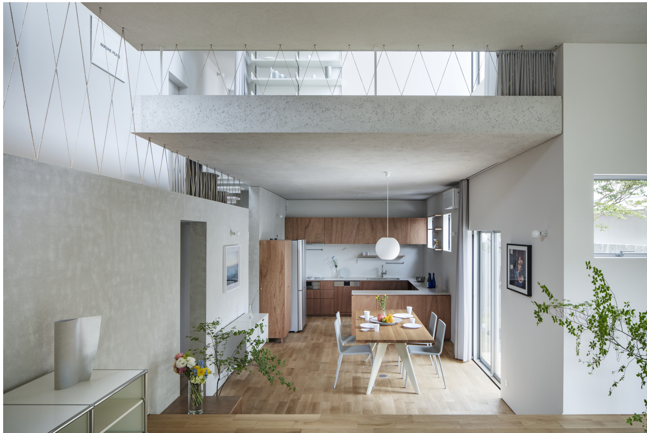
1階リビングからダイニングと2階和室を同時に見る。和室の床は上部鉄骨梁より丸鋼で吊られている
