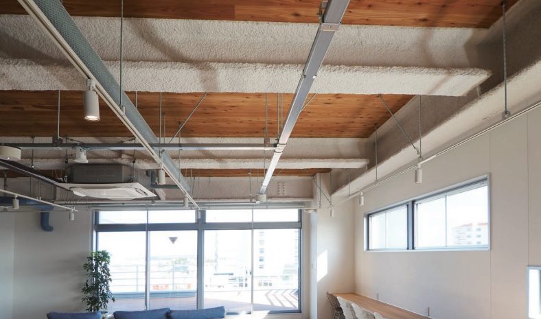
橋本組本社ビルの内観。天井仕上としての意匠性と省エネ性能を両立したCLT床版。
