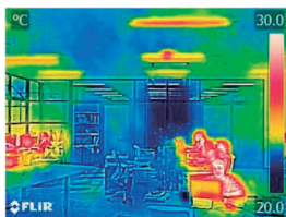
冷房時、画像中央のPS HR-Cの中を冷水が循環することでオフィス全体が涼しい環境に保たれている。(サーモグラフィ：2022/8/31 撮影)
