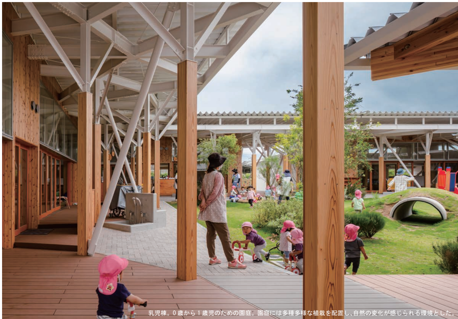
3歳児棟から園庭を望む。建物から4.5mはね出した半屋外スペースによって屋内的活動と屋外の活動が同居し、シームレスな子どもの活動を可能とする。
