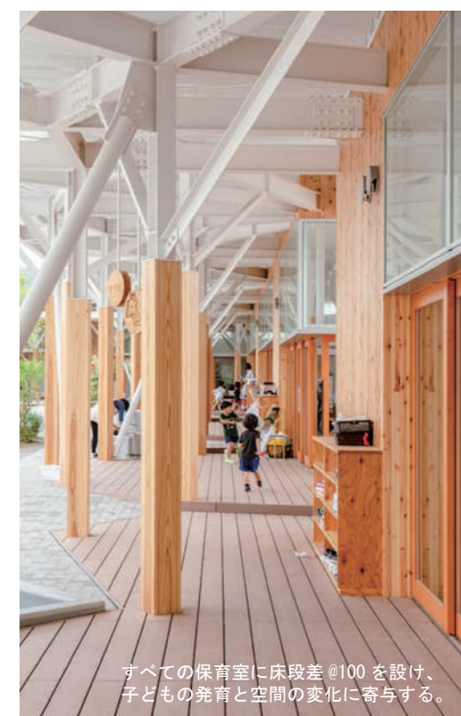
12角形の柱：H-125×125×6×9はスギ板をあしらい木の幹に見立て、 方柱：CT-100×100×5.5×8は円の中心と軒先に向かって伸ばし木の枝に見立てた。
