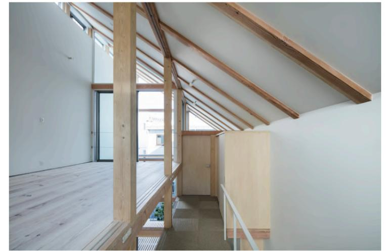
床が段違いにずれることで、最頂部に設けた開口部により、建物全体で立体的に上方への通風、採光、視線の抜けを確保している。
