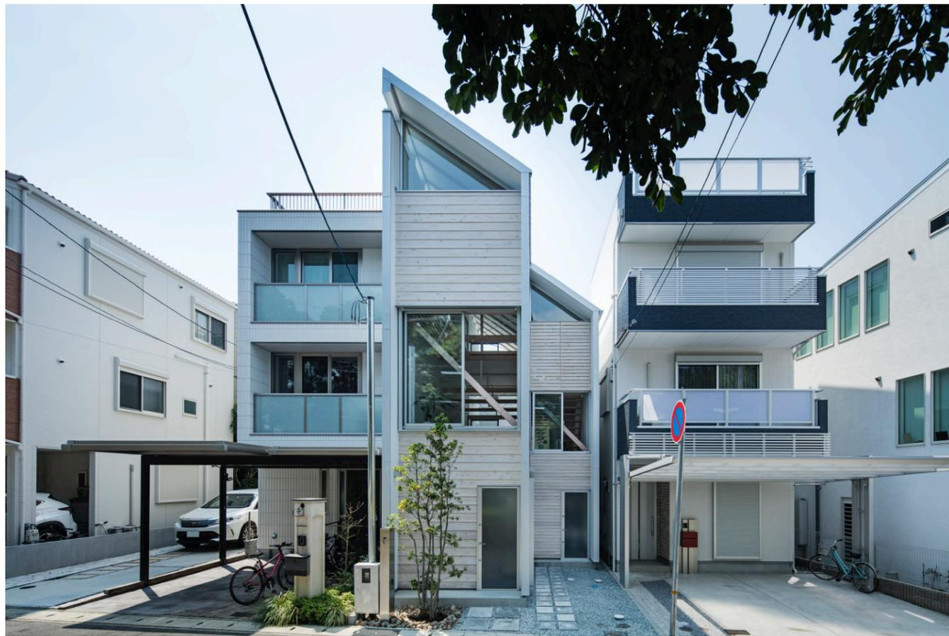
北側外観。長手方向にボリュームを2分割し、その片側に設備類を寄せることで、視線が抜ける空間を確保するとともに、独特な縦長プロポーションが現れている。
