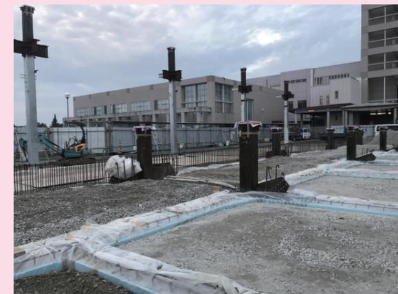
今回の構造計画はブレース造の為、埋め戻しの際にブレースが邪魔となり重機が1階に侵入し難い。ベースプレートと一体の1階中間までの柱を、基礎に先行して設置し基礎コンクリートに打ち込むことで、鉄骨建て方前に埋め戻しが可能となり、工期も短縮された。
