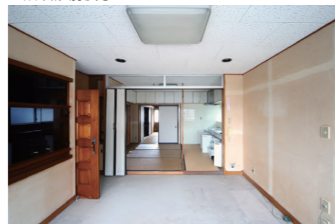
既存2階住宅内観(南側から北方向を見る)
