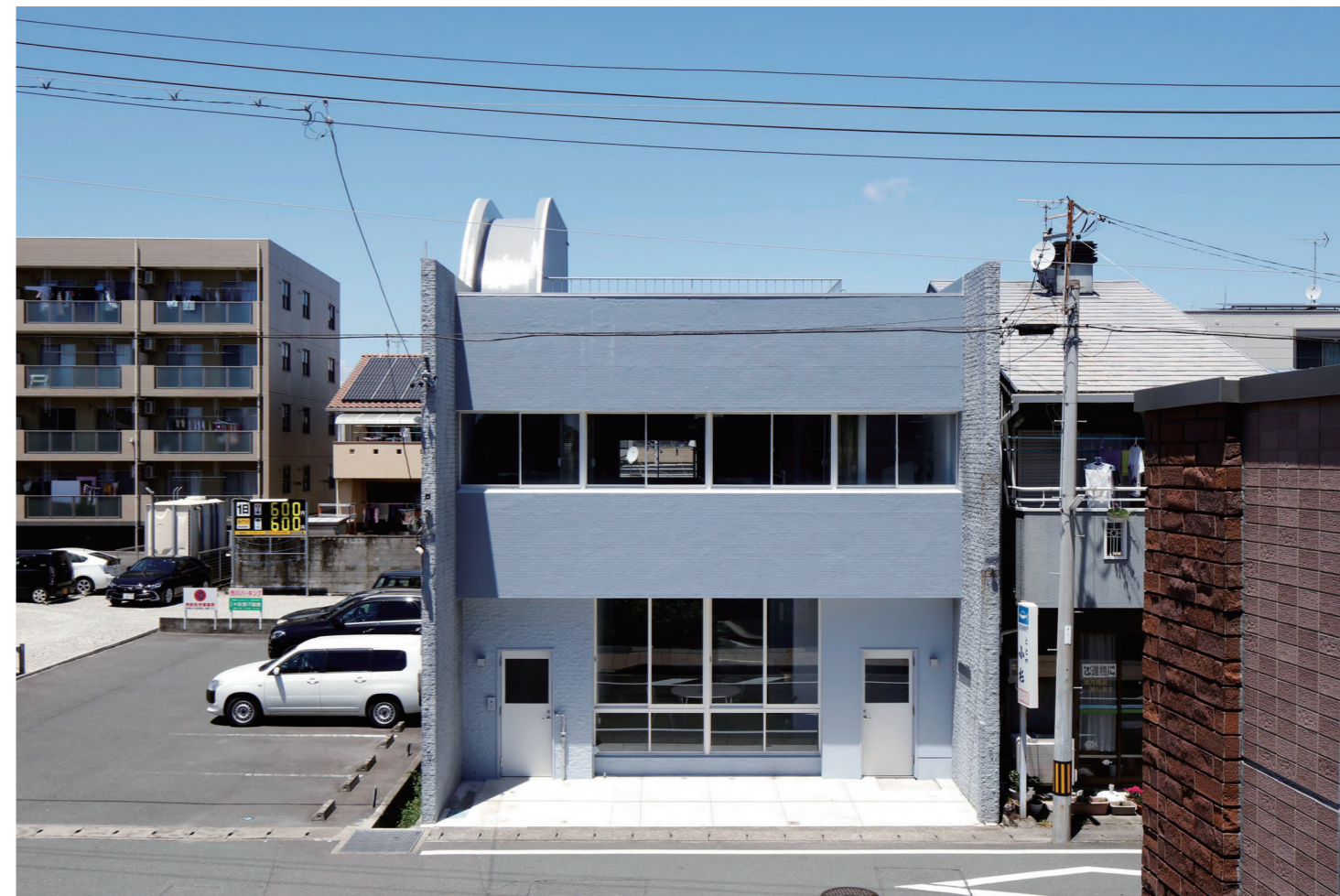
改修後南ファサード
