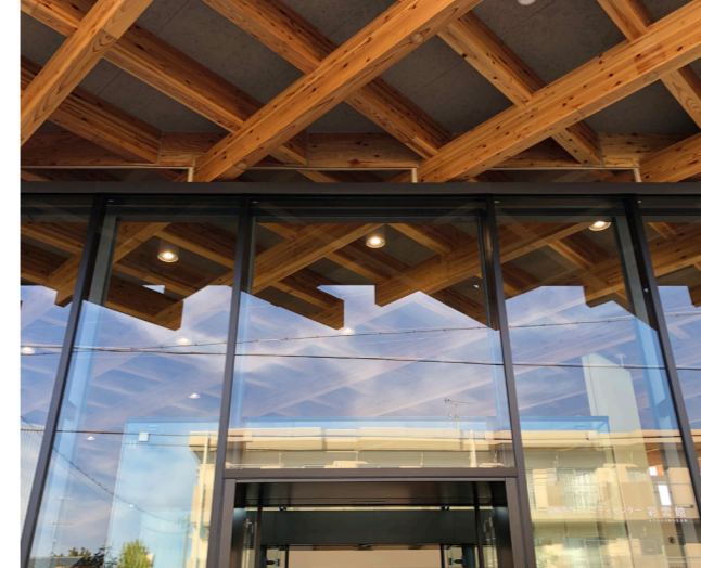
エントランスからフロントサッシを見る。
