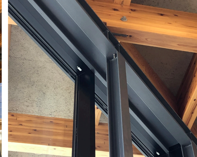
サッシと間柱位置を揃えファサードの透明性を高める。
