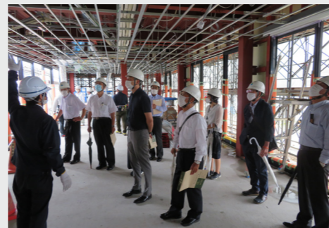
施工中の工事現場に市民を案内
