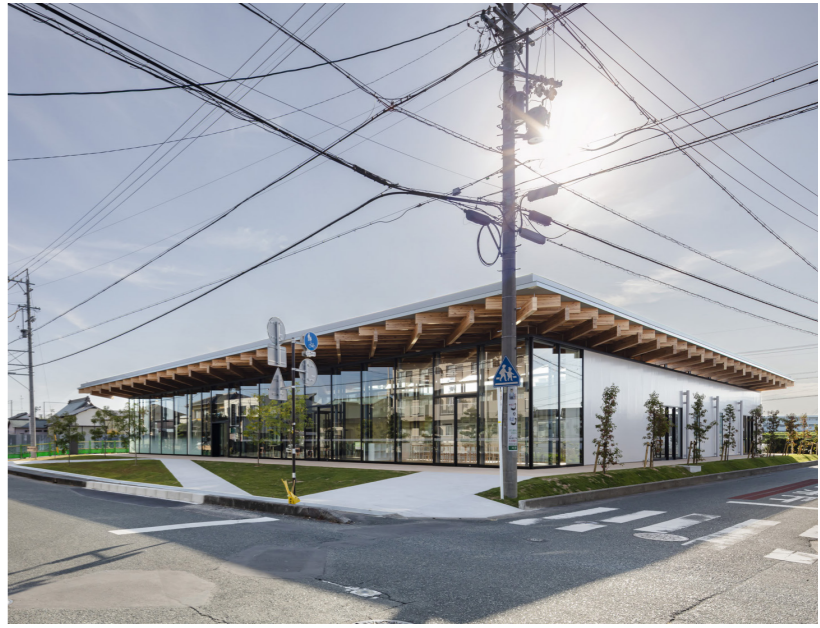
北東地上から見る。建物の内部まで段差を設けず、シームレスなアプローチを可能にする。
