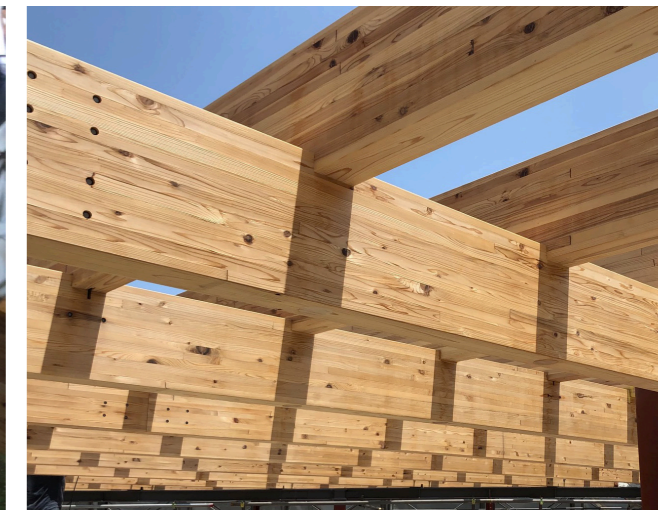
格子梁の組上げ施工風景。接合はスチールプレートにドリフトピンにて固定。
