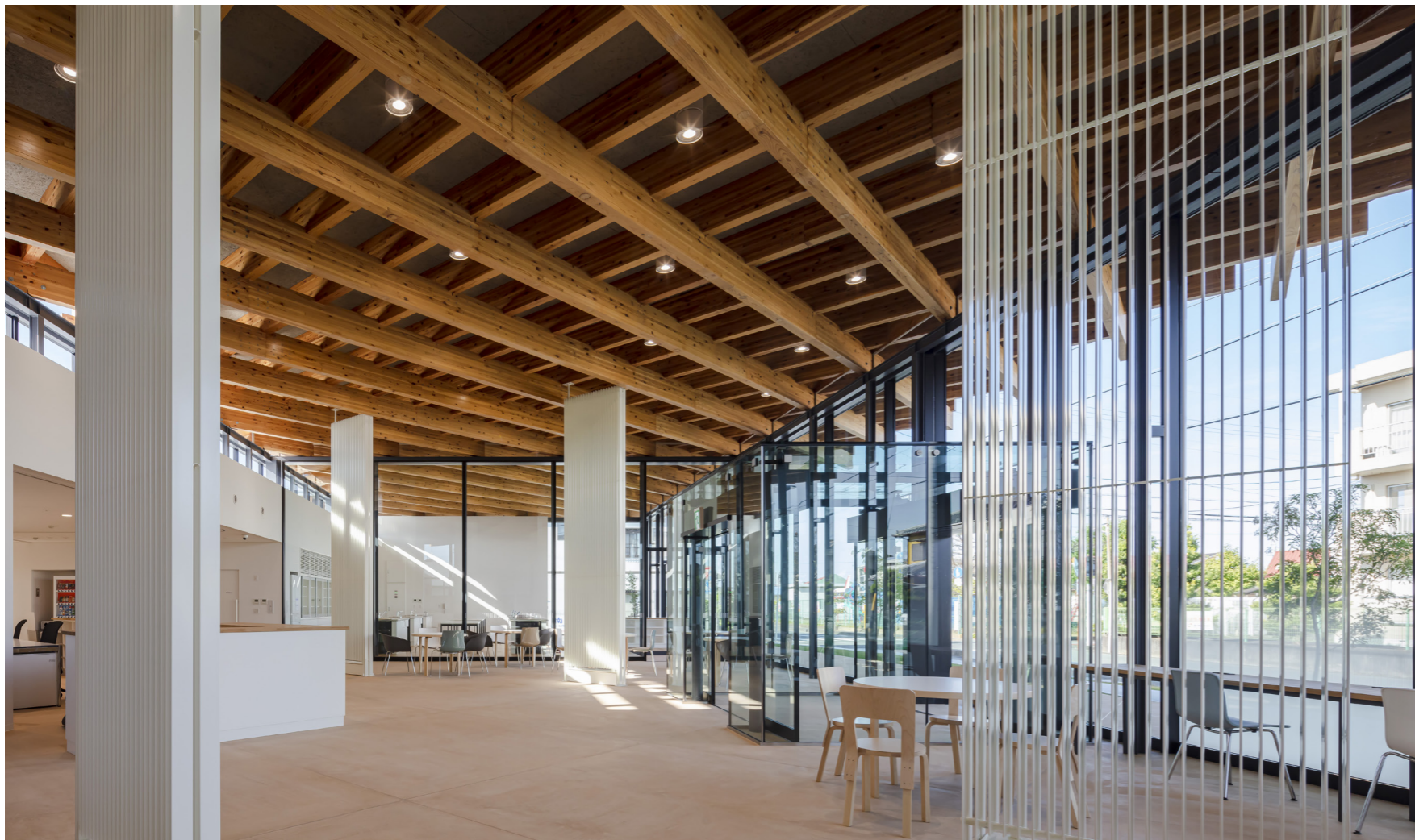
オープンスペースからキッチンスタジオ（たまり縁）を望む。床は色モルタル仕上げとし、市民が気軽に立ち寄りやすい空間を目指した。格子梁に合わせて輻射パネルを配置し、機能と空間の間仕切りを兼ね備えたデザイン。右手前は北側学習コーナー。輻射パネルが緩やかに領域を作る。
