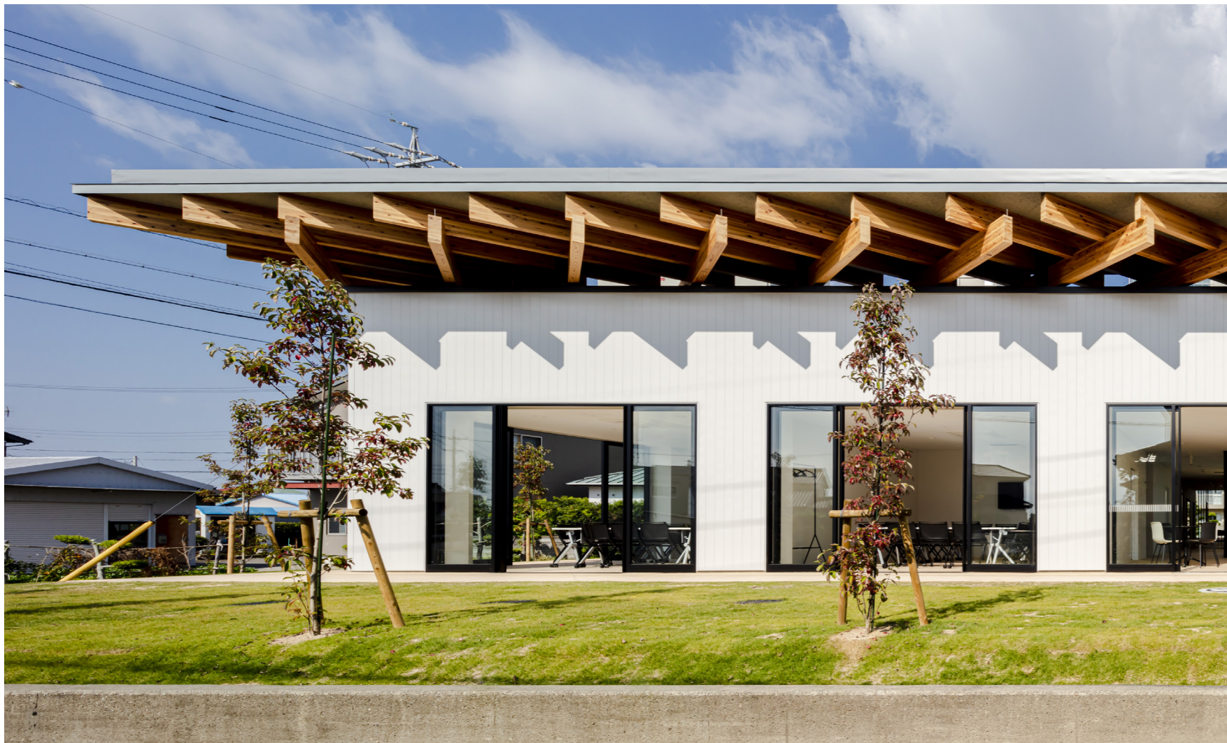
格子梁の上弦材は野地板木毛セメント板 3 × 6 板の施工性を考慮して @910mm に設定。下弦材は構造計画の合理性と軒先のリズムが生まれるように上弦材の 1.5 倍の @1,365mm に設定。
